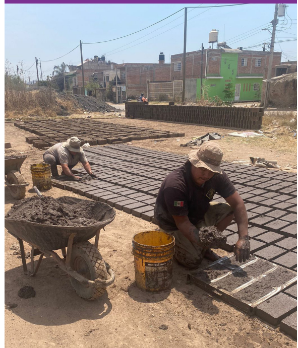
Obreros formando ladrillos.
